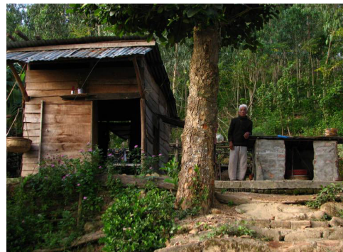
Nơi trú bão được xây dựng sau khi trải qua cơn bão kinh hoàng Xangsane, Photo by IFRC
